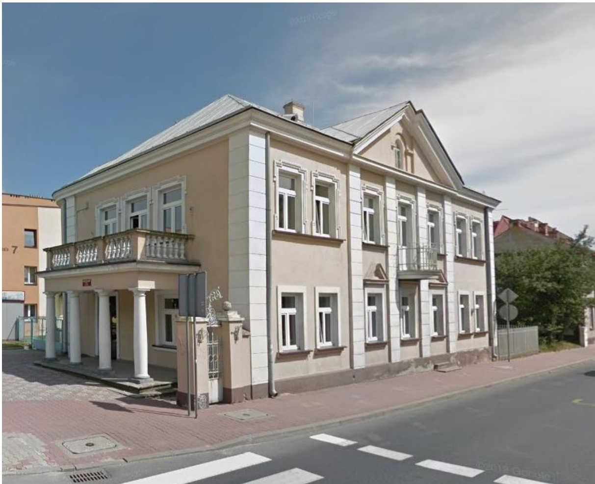
Ryc. 30 – Zabytkowy budynek - lokalizacja Centrum Wielopokoleniowego - przedsięwzięcia C11
